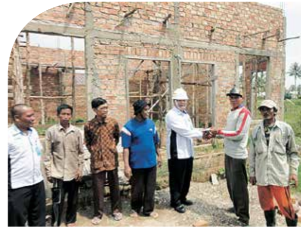
Pembangunan Musholla Al Mubarak di Kecamatan Indralaya Utara, Kabupaten Ogan Ilir
